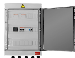
Skrzynka dla systemu podtrzymania baterijnego (SMA, Fronius)
